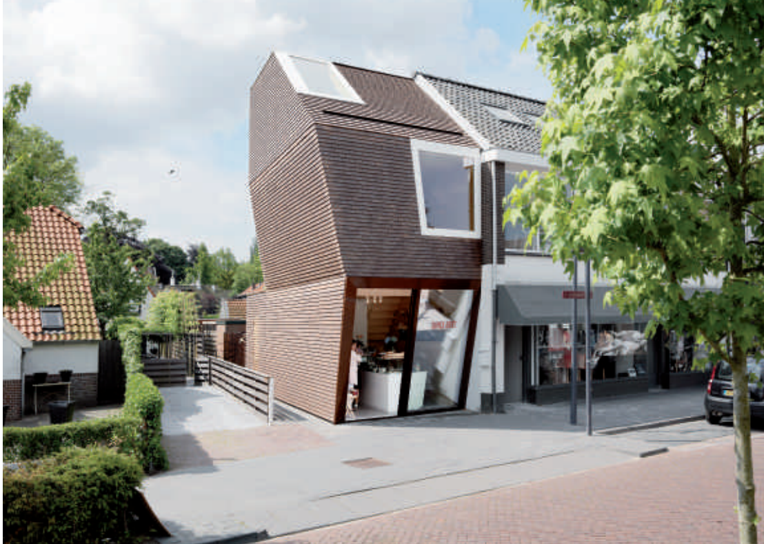
De eetwinkel is gesitueerd tussen een woonhuis uit het begin van de 20ste eeuw met recht van overpad en een pand uit de jaren 1970.
